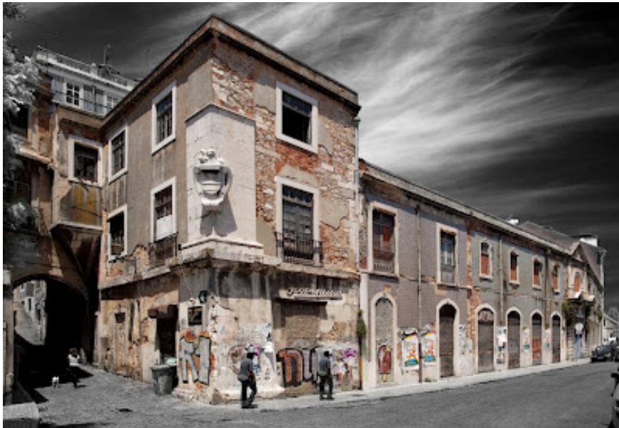
Fig. 6) Lisboa, Palácio dos Condes de Coculim, Rua dos Cais de Santarém, 1ª metade do séc. XVII?, estado actual
