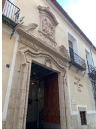
Fig. 8) Valencia, Fachada del Colegio de la Seda (foto © Víctor Iborra Romero)
