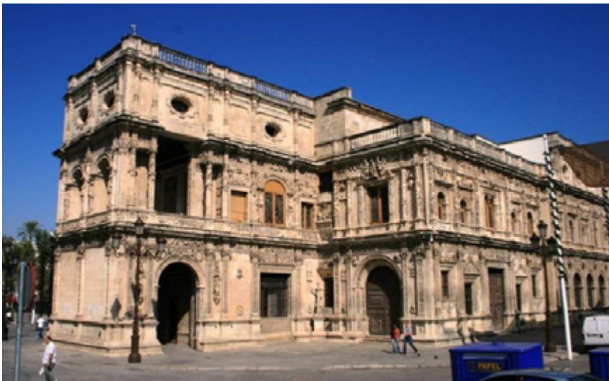
Fig. 4) Diego de Riaño y otros, Ayuntamiento de Sevilla , a partir de 1526, Sevilla, estado actual
