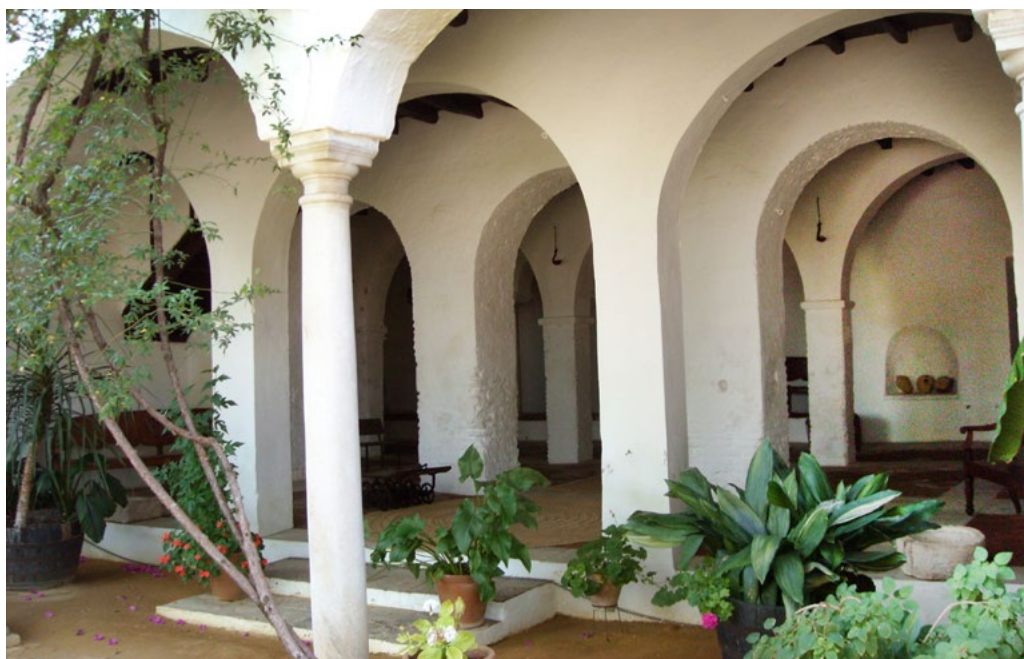
Fig. 3. Palacio ducal de Medina Sidonia, Sanlúcar de Barrameda. Ala este, formada por cinco galerías. (Fotografía del autor).
