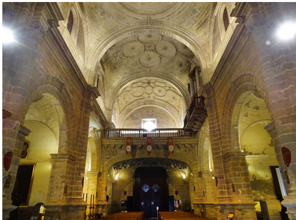
Fig. 1. Antiguo convento de Santo Domingo de Guzmán, actual parroquia de ese nombre, Sanlúcar de Barrameda. Interior hacia los pies. (Fotografía del autor).
