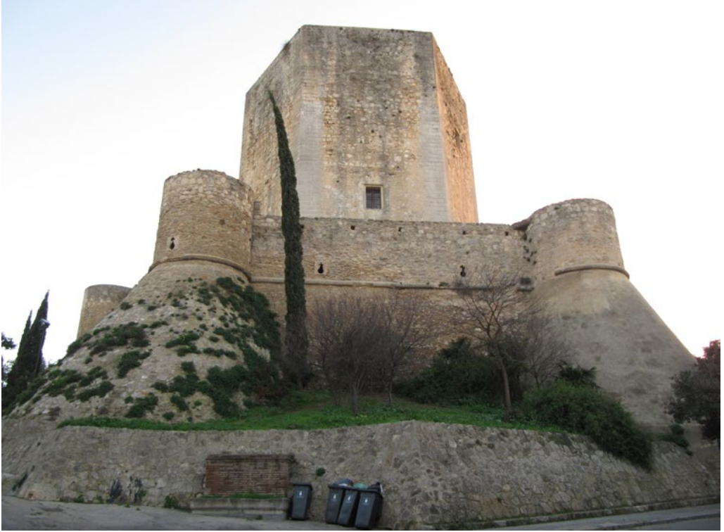
Fig. 7. Castillo de Santiago, Sanlúcar de Barrameda. Falsabraga artillada que envuelve la torre del Homenaje. (Fotografía del autor).
