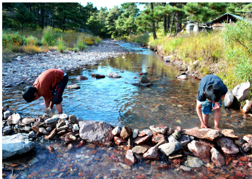
Figura 12. Construcción de muralla en el río de la Aldea (2016).
