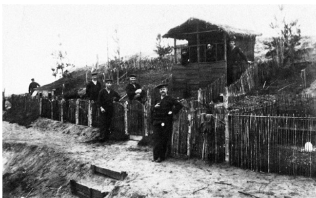
Marinos alemanes y pérgolas construidas en la isla Quiriquina.
