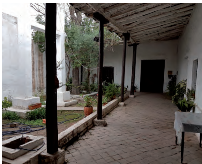
Fig. 4. Galería, entrada a la Capilla. Fotografía: Victoria S. Piseghelli.
