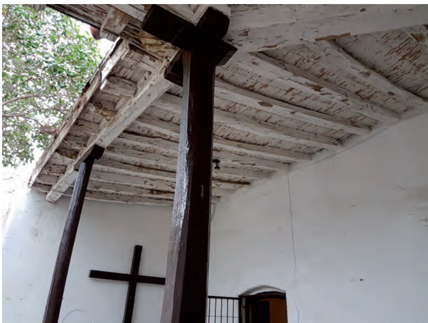
Fig. 3. Techo, técnica tumbadillo. Fotografía: V. S. Piseghelli.
