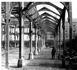
A la izquierda, armazón metálico del Mercado Central montado en Escocia antes de su envío a Chile. Colección fotográfica de la Biblioteca del Real Instituto de Arquitectos Británicos, en Guedes, 2006. A la derecha, Mercado Central, ca. 1884. Colección de fotografía histórica del Mercado Central de Santiago (Chile).
