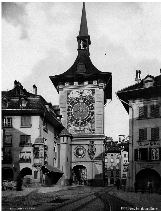
Zeitglockenturm (torre del reloj). Berna, 1890. Fotografía de Schroeder & Co. Zúrich (Suiza).
